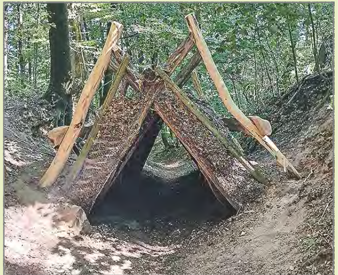
Der Laubtunnel auf dem Walderlebnispfad wurde restauriert: Unter der fachlichen Anleitung von Burkhard Pritsch wurden bei einem Arbeitseinsatz weitere Robinienstämme an den vorhandenen, immer noch sehr stabilen Stämmen befestigt – jetzt hat die Konstruktion wieder Spannung. Foto: Klaus Mayer
