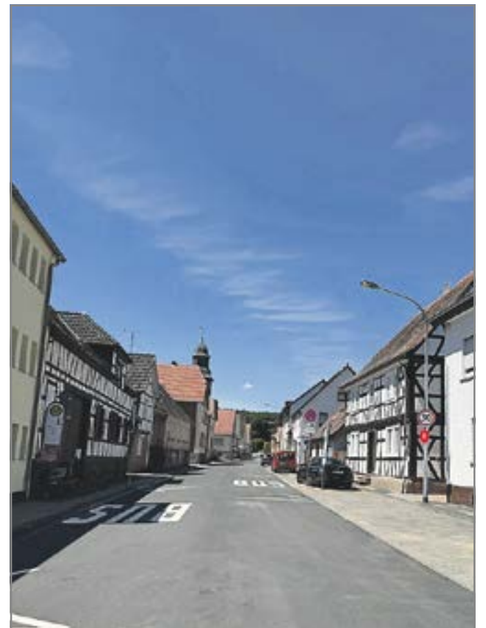
Wieder freie Fahrt durch den Stadtteil: Die Bauarbeiten an der Ortsdurchfahrt Wembach sind beendet. Foto: Stadt OR
