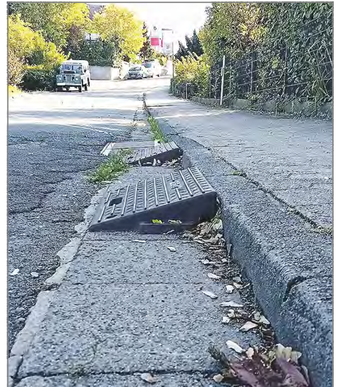
Hindernisse im öffentlichen Verkehrsraum: Die Rampen können für Passanten oder Radfahrer zur Gefahr werden und den Regenwasserabfluss behindern. Foto: GdM
