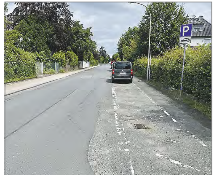
Einfache, aber wirkungsvolle Maßnahme: Das Bild zeigt die fehlende Markierung in der Alten Darmstädter Straße. Im Sommer wird der Gehweg verbreitert. Foto: Benjamin Buchholz
