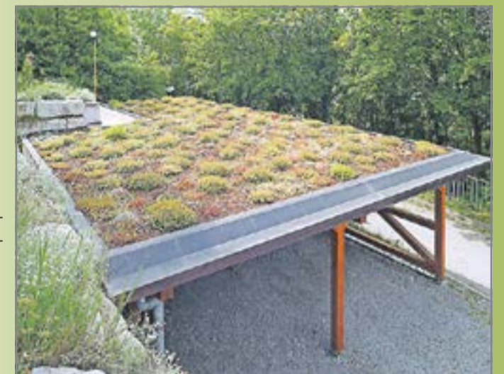
Kleine Dachfläche, große Wirkung: Begrünungen von Carport, Garage oder Gartenhäuschen verbessern das urbane Mikroklima. Foto: DJD/Paul Bauder
