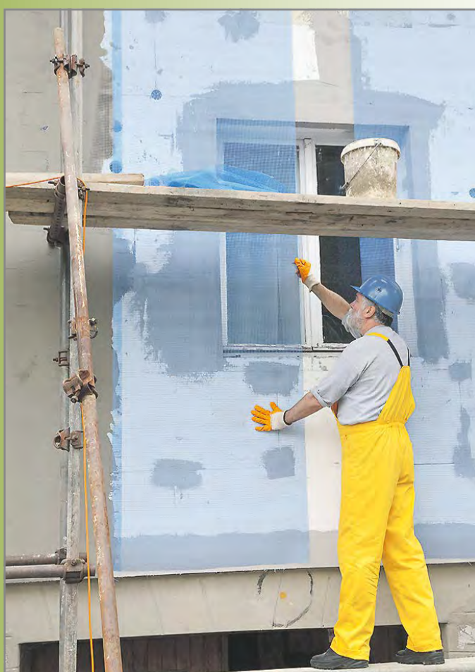
Die Dämmung der Fassade ist der erste Schritt zu mehr Energieeffizienz und Klimaschutz in älteren Gebäuden. Foto: DJD/IVH/Getty/simazoran
