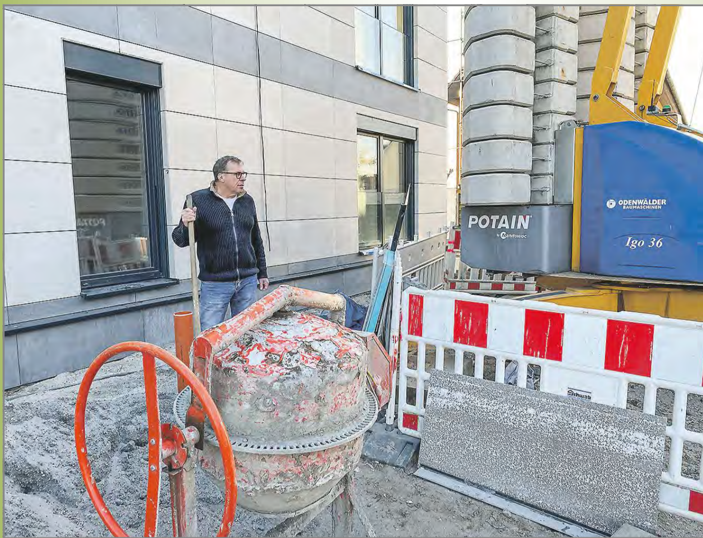
Energetische Baubegleitung vor Ort um sicherzustellen, dass die Fenster und die Dämmung auch wie berechnet richtig eingebaut werden. Foto: heat consult Energieberatung
