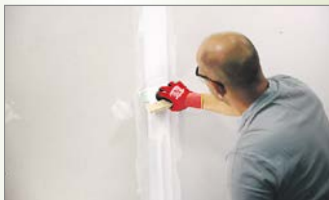
Selbst ist der Heimwerker: Löcher schließen oder Fugen von Gipskartonplatten spachteln - solche Aufgaben lassen sich mühelos und schnell erledigen. Foto: DJD/Saint-Gobain Weber
