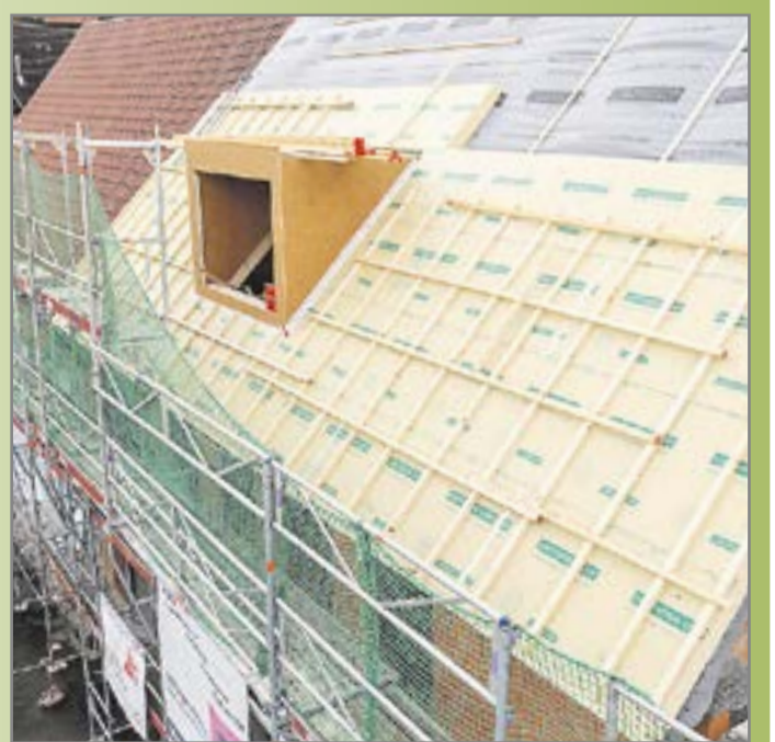
Mit Wärmeleitfähigkeitsstufe 023 hohe Dämmeffizienz bieten: Unter Umständen können Bauherren eine Dachsanierung durch verschiedene Stellen fördern lassen. Foto: DJD/Linzmeier Bauelemente
