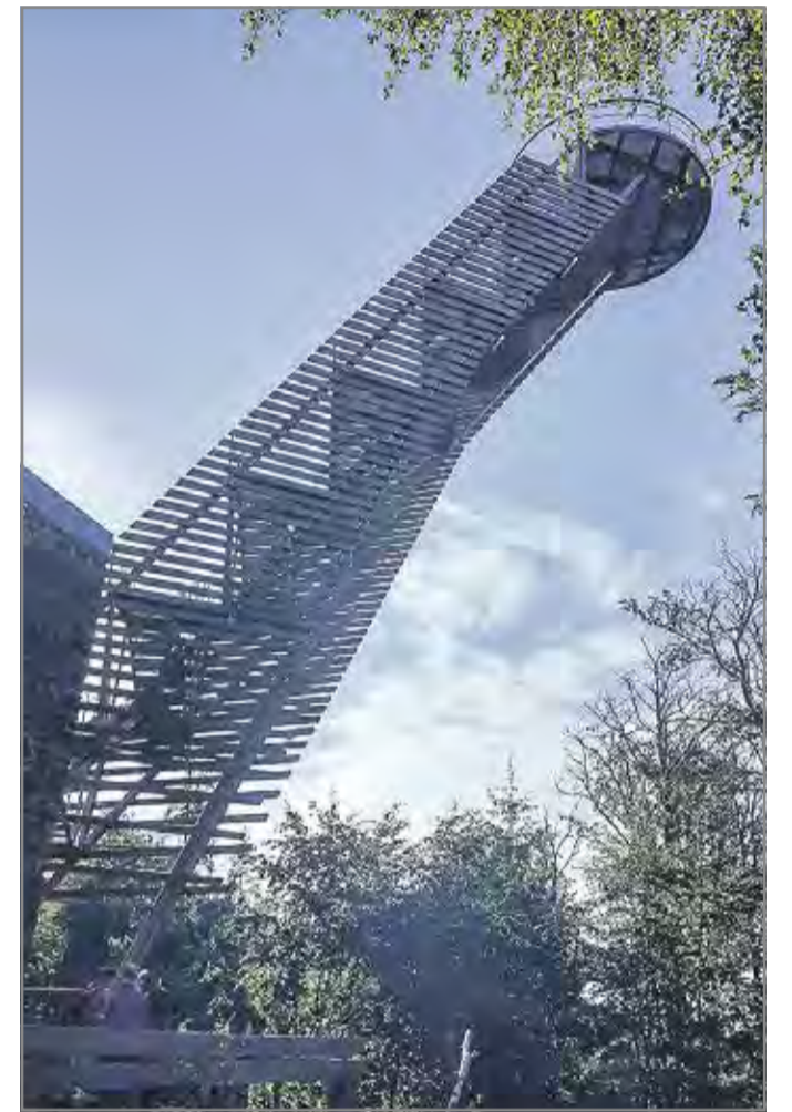
Ein Hingucker: Der neue Aussichtsturm auf der Tromm wird wegen seiner starken Schräglage auch als Himmelsleiter bezeichnet. 33,60 Meter hoch, müssen insgesamt 192 Stufen erklimmt werden. Foto: Inge Schneider-Plößler
