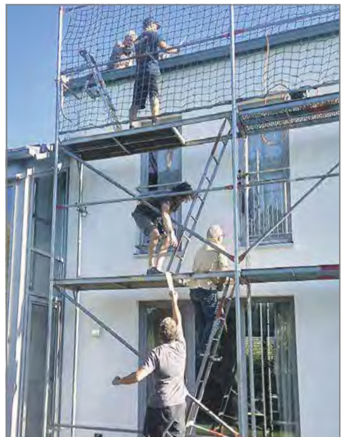
Gemeinsam geht es besser: Die KLIO-Kerngruppe für den solidarischen Selbstbau von PV-Dachanlagen in Aktion in Frankenhausen. Foto: Monika Anton
