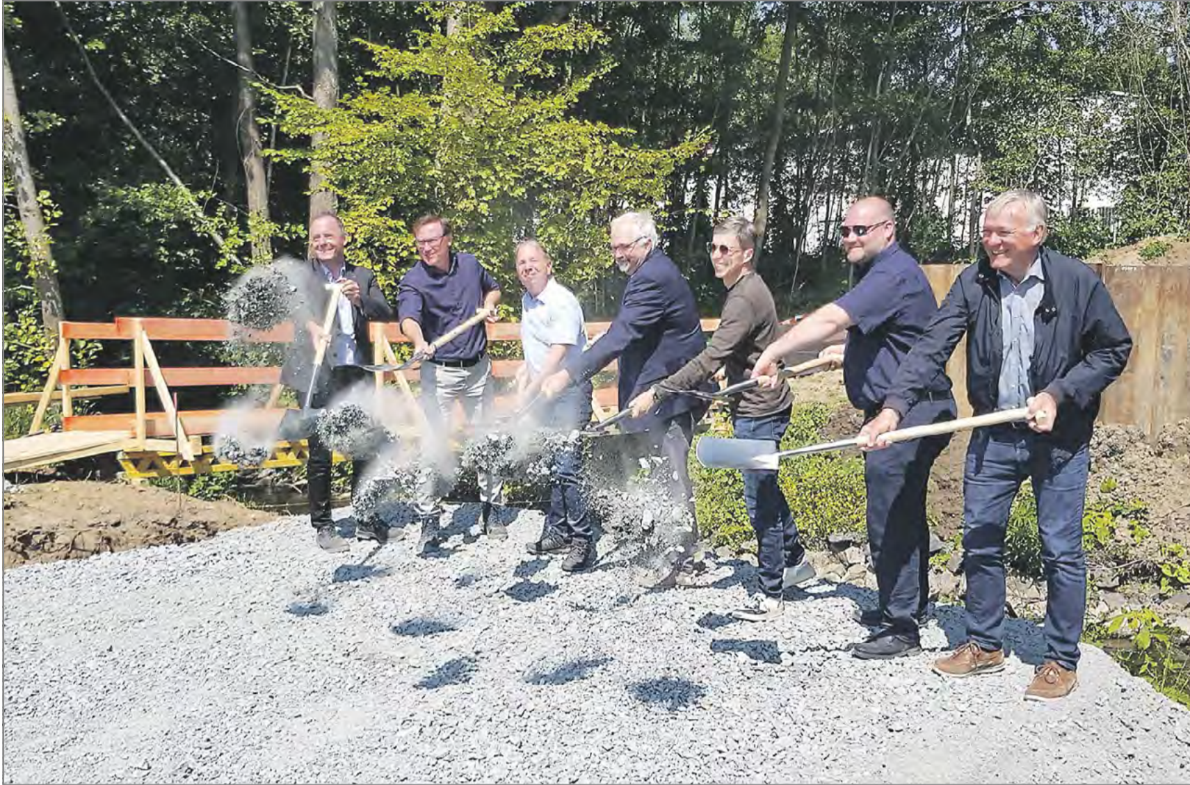
Symbolischer Baubeginn: Den tatkräftigen Startschuss gaben (von links) Stefan Jung-Diefenbach von Bauunternehmung Albert Weil AG, Ulrich Wollenschläger und Karsten Kutschera von der Gemeinde Mühltal, Bürgermeister Willi Muth, Heiko Müller, Geschäftsführer von Riese & Müller, Ortsvorsteher Niels Starke sowie Martin Bullermann, Büro UBS. Foto: Umweltplanung Bullermann Schneble
